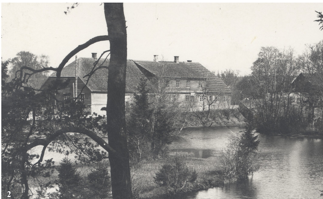
1-2) Vaated Tõrva (Patküla) vesiveskile Veski tn poolt üle veskijärve 20. sajandi algul (1) ja 1930. aastate esimesel poolel (2). Veskihoonel on sindelkatus, puitseinad on kaetud rõhtlaudvoodriga. Katuseväljaehitus on üksnes hoone põhjapoolse hooneosa kohal. Nii põhi- kui pööningukorruse aknad on 6 ruuduga. Avade asukohad fassaadil vastavad praegustele. Fotod Hillar-Jüri Villemsoni (1) ja Jaan Vali (2) kogust.
