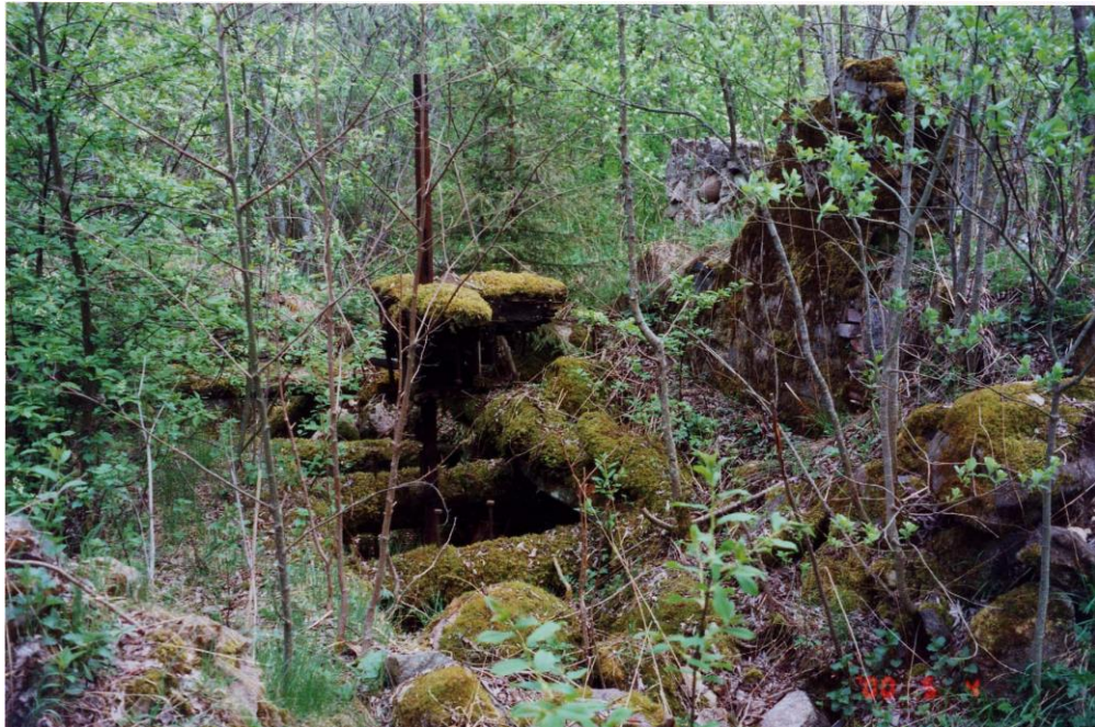
Joon 2.3.9.1 Kaubi veskit on järele jäänud mälestus, vundamendid ja turbiini säilmed. Objekt väärrib konserveerimist, taastamine veejõujaamana ning turismiobjektina tooks omanikule kasu
